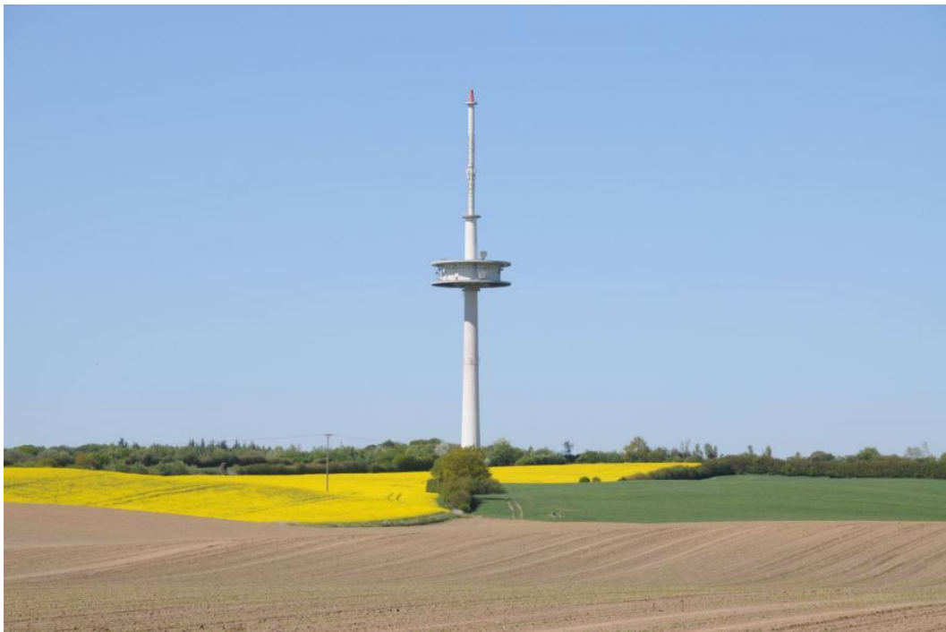
Abbildung 3: Sendeturm Höckeberg (Quelle: www.freienwill.de )
